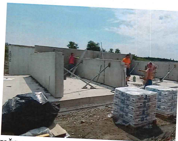
UČS 10, Montáž prefa, transformátorovňa
