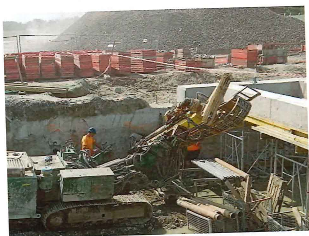
UČS 11, Kotvenie stien podjazd
