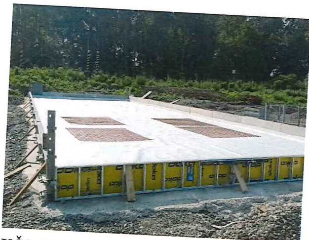
UČS 10, Armovanie základovej dosky, TNS Kúty stanovište transformátorov
