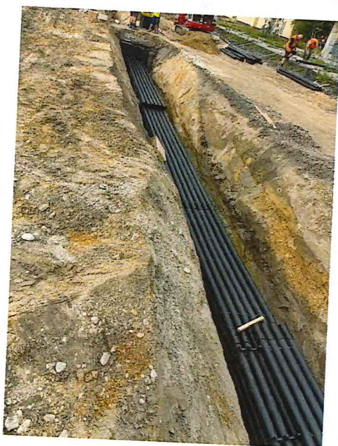
UČS 02, Realizácia kábelových trás
