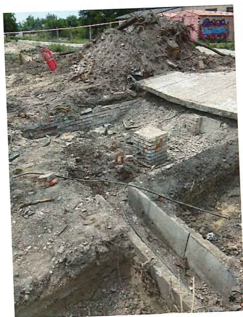
UČS 02, Vyberanie nefunkčných káblov, obnaženie funkčných trás, búranie betónov
