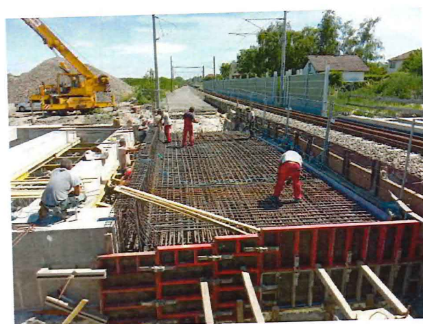
UČS 11, Armovanie mostovky, podjazd
