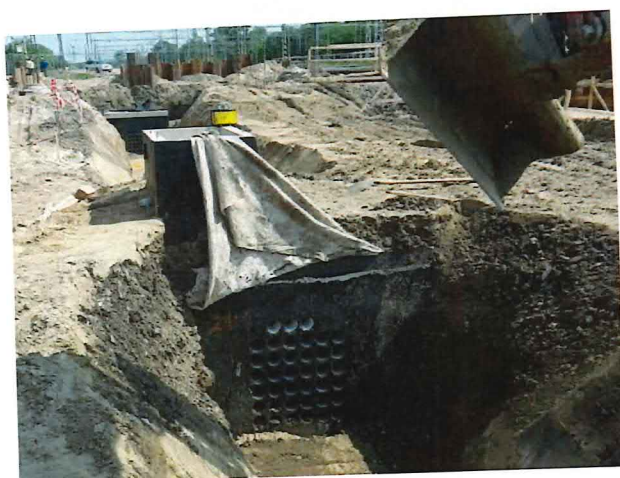
UČS 02, Realizácia kábelových trás
