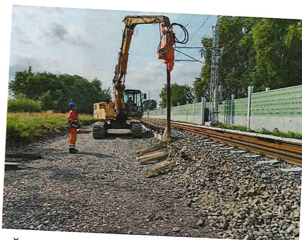
UČS 10, Rušenie záporového paženia HEB
