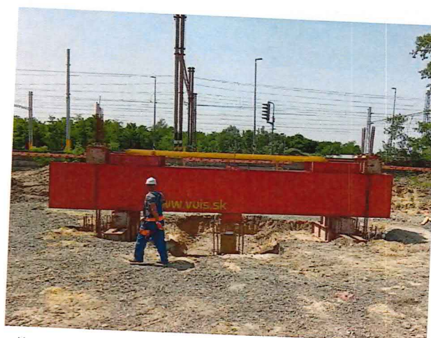
UČS 02, Zaťažovacia skúška pilóty príprava
