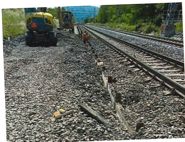
UČS 01, Realizácia záporového paženia
