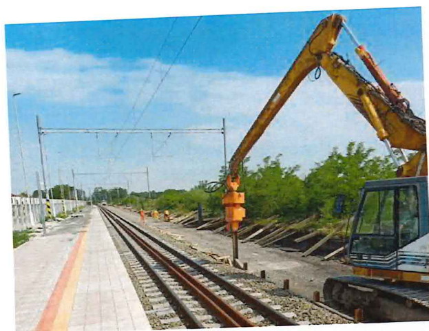
UČS 10, Rušenie záporového paženia
