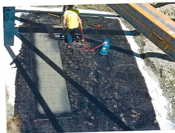
UČS 11, Realizácia podkladného betónu, a hydroizolácie
