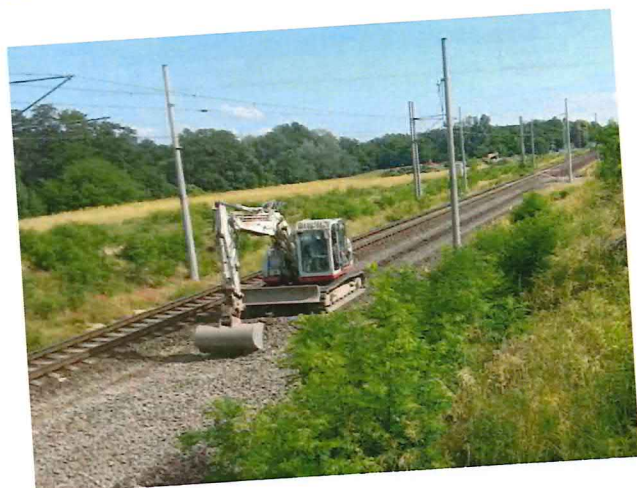
UČS 01, Odt'áženie starého koľajového kameňa
