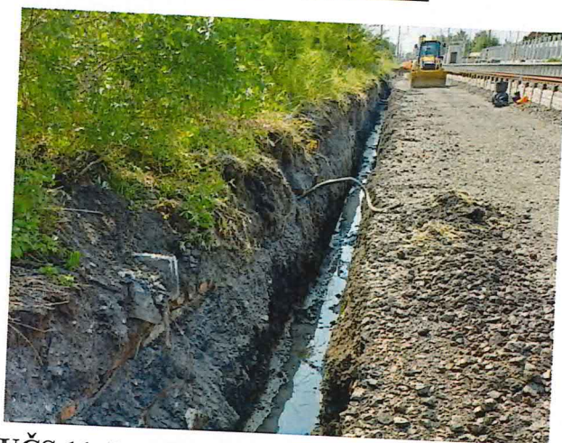
UČS 11, Realizácia drenážneho odvodnenia
