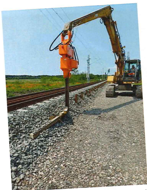
UČS 11, Rušenie záporového paženia HEB
