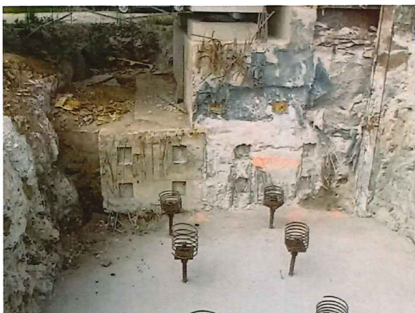
UČS 12, Realizácia podkladných betónov a šmyková výstuž
