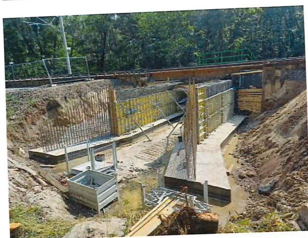
UČS 10, Armovanie, debnenie a betonáž stien priepustu
